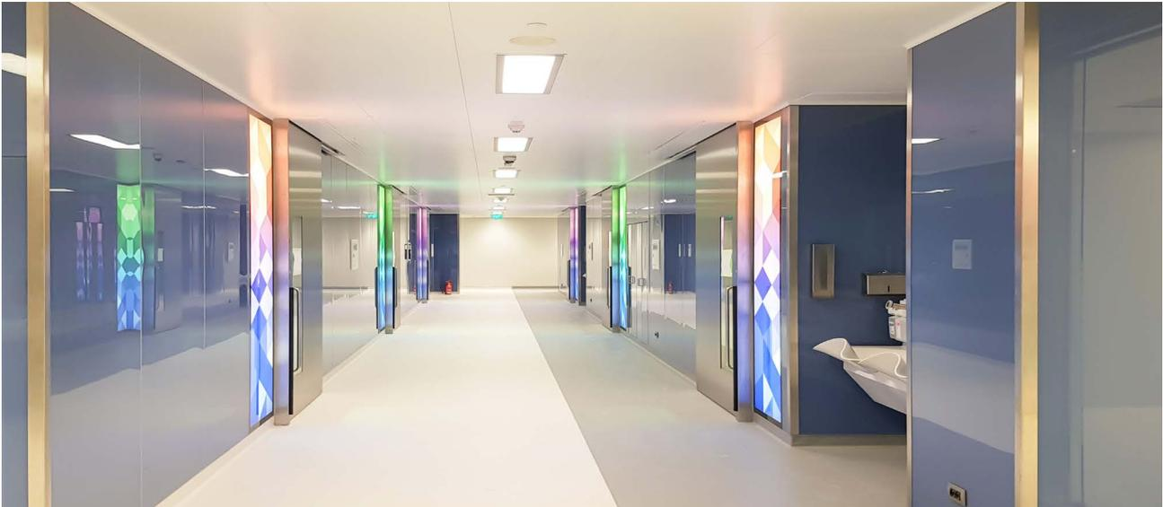
Die Glas-Paneelwand mit LED-Beleuchtung bietet neue Design-Aspekte für den OP-Bereich. Ein satiniertes VSG-Glas mit umlaufendem schwarzen Rand wird rückseitig vollflächig mit
