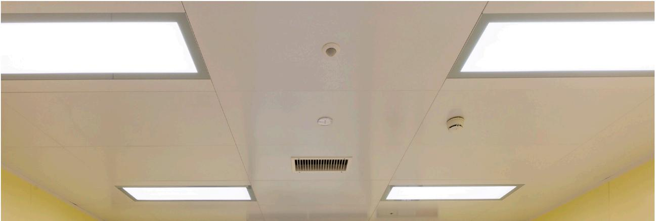
Die Deckenkassetten sind auf das Achsrastermaß der Wandsysteme und der Deckeneinbauten abgestimmt und einzeln revisionierbar. Anschluss- und Passkassetten ergänzen die übrigen Flächen. Die Deckenkassetten bestehen aus verzinktem, in weiß beschichtetem Stahlblech (ähnlich RAL 9016). Die Unterkonstruktion besteht aus einem Verbund von Trag- und Querprofilen.
