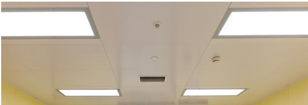
Die Deckenkassetten sind auf das Achsrastermaß der Wandsysteme und der Deckeneinbauten abgestimmt und einzeln revisionierbar. Anschluss- und Passkassetten ergänzen die übrigen Flächen. Die Deckenkassetten bestehen aus verzinktem, in weiß ähnlich RAL 9016 foliertem Stahlblech. Die Unterkonstruktion besteht aus einem Verbund von Trage- und Querprofilen.
